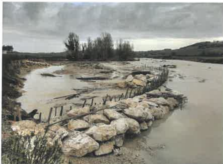
Documentazione fotografica della realizzazione dei pennelli da parte della Provincia nell'anno 2016.
